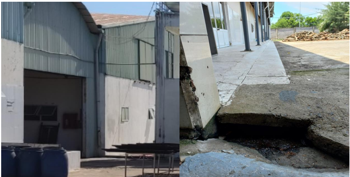
Hình 3.2. Ống dẫn nước mưa từ máng thu xuống mặt đất và hố ga thu gom
